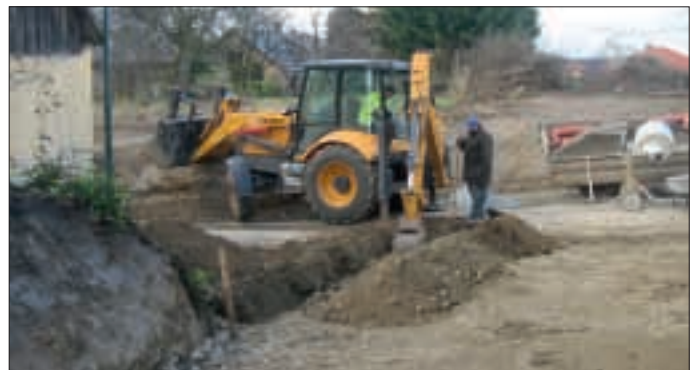
Im südlichen Hintaus von Hohenwarth musste eine Entwässerung hergestellt werden. Schwere Geräte, vor allem Bagger, erleichtern den Männern des Gemeindebauhofes die Arbeit.
