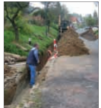
In Ronthal musste ein Teil des Regenwasserkanals erneuert werden. Fotos: Mold
