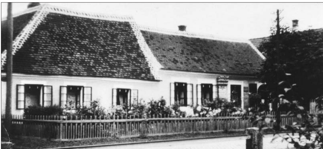
Das Geburtshaus von Norbert Tischelmayer in Mühlbach Nr. 48, an der Duchzugsstraße, der Bundesstraße 35 gelegen, ist bereits seit vielen Jahren einem Neubau gewichen.
