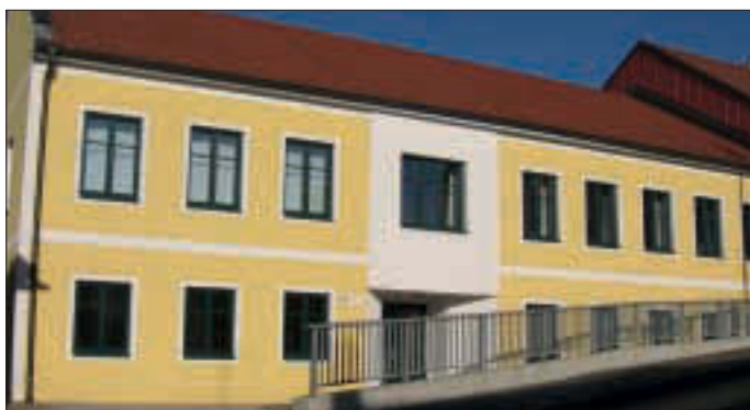
Nach mehrjähriger Bauzeit wird am 10. April das Gemeinde- und Kulturzentrum in Hohenwarth durch LH Dr. Erwin Pröll eröffnet.
